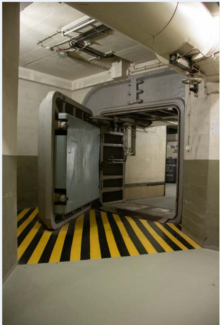
Zwäre toegangsdeur van West-Duitse regeringsnoodzetel, nu Dokumentationsstätte, in Ahrweiler
