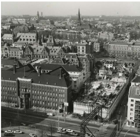
Voorbereidingen voor afzinken van Defensienoodzetel, 1985. Foto archief Den Haag
