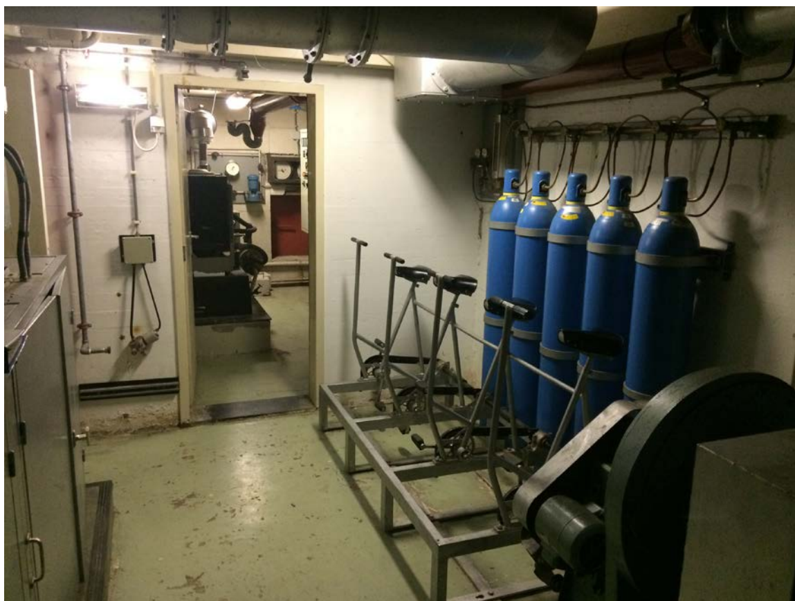
Noodzetel van het ministerie van Landbouw en Visserij in Den Haag voorzien van zuurstoftanks en fietsen voor aandrijving van luchtvoorziening en zuurstoftanks
