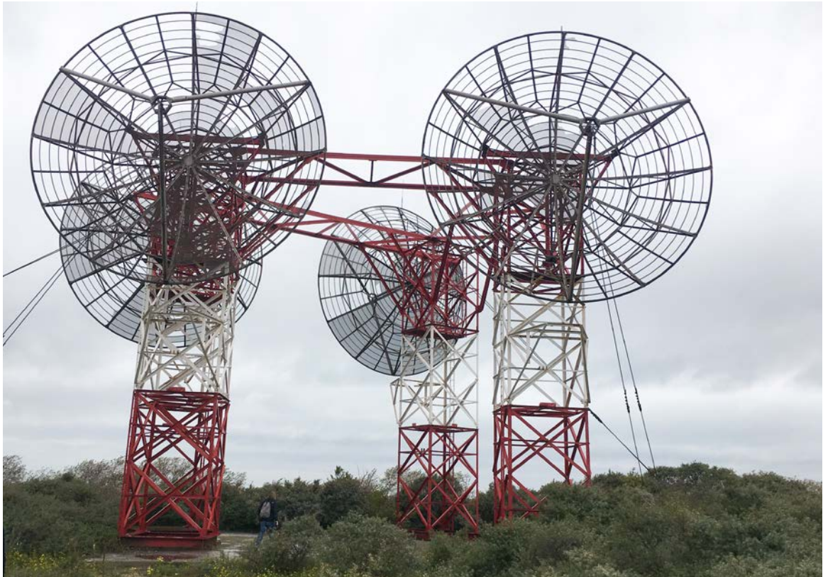
Amerikaanse Troposcatter (1967) als overblijfsel van een voormalig radio relay station uit de Koude Oorlog in het militair-historisch gelaagde Vinetaduin bij Hoek van Holland. De markante parabolantennes werden ingezet voor het ontvangen en doorstralen van berichten vanuit West-Duitsland (Wiesbaden) via het Verenigd Koninkrijk naar de Verenigde Staten (Washington). Foto Ben de Vries
