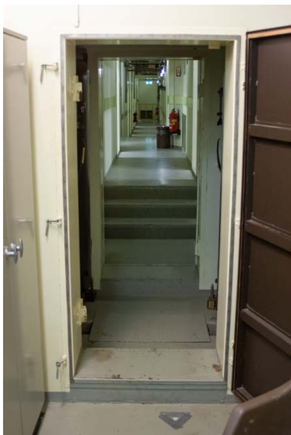
Kijkend vanuit Hazeleger in een gang van Nachtwacht. Halverwege die gang zit een verhoging met links en rechts ruimtes met verende, schokvrije vloeren
