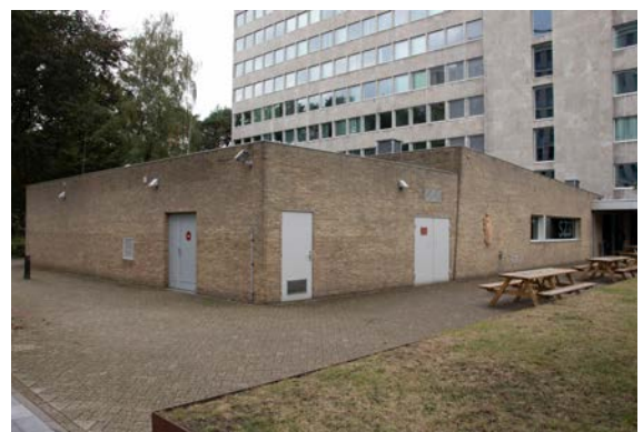
De laagbouw waaronder zich de noodzetel van het ministerie van Landbouw en Visserij in Tilburg bevindt
