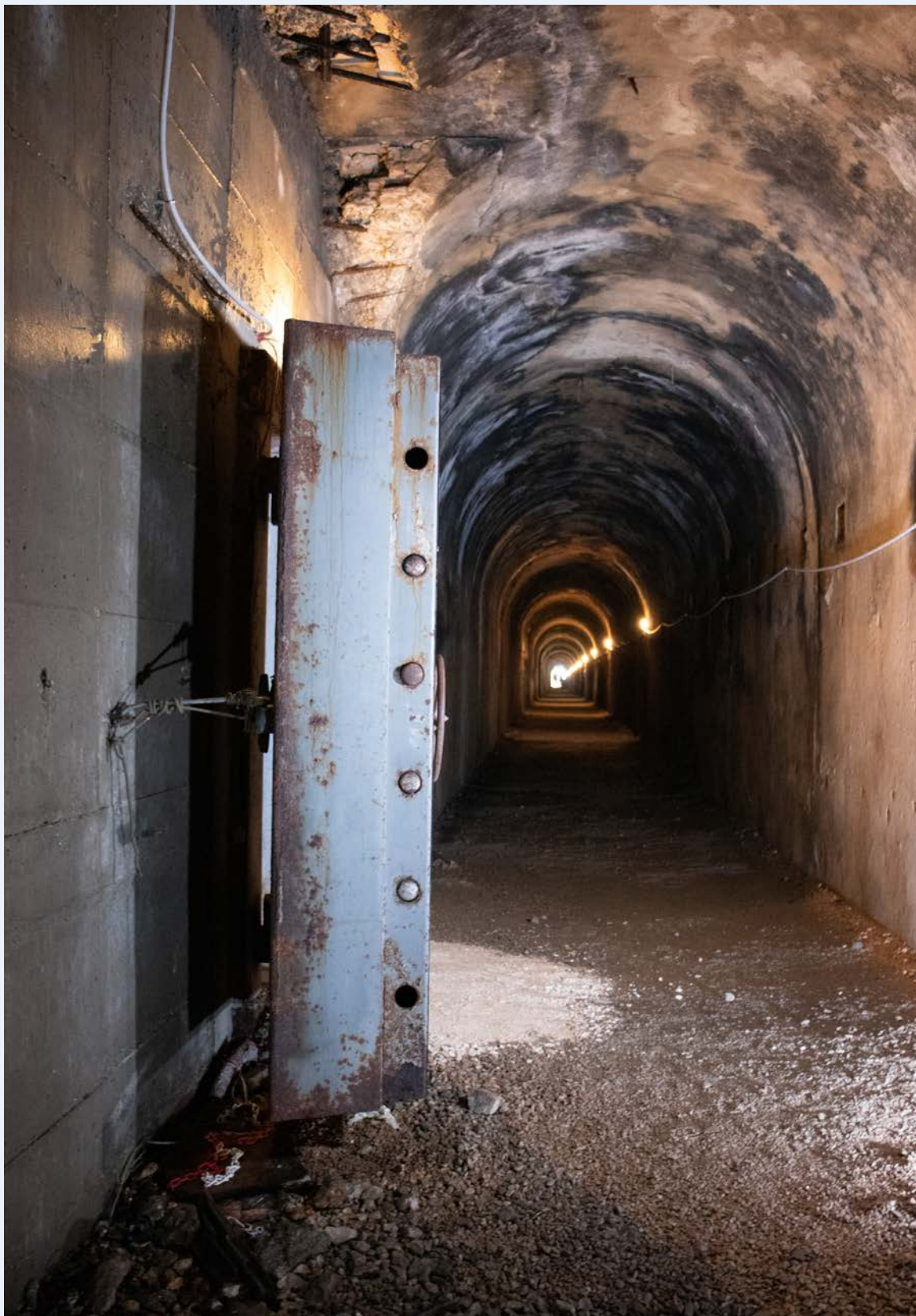
Tunnel naast de ingang van de Italiaanse regeringsbunker del Soratte
